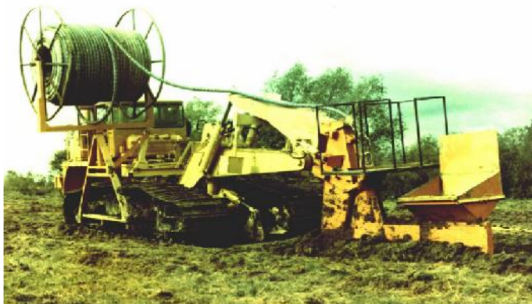
Рисунок 1 - Укладка дрены с фильтром из нетканого материала
